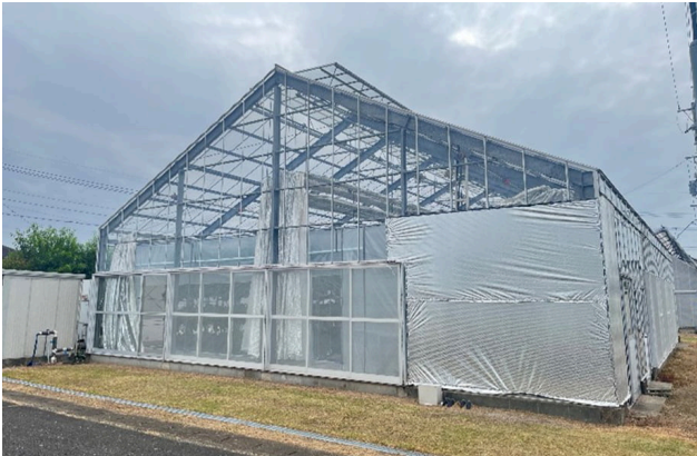
九州電力研究施設外観(佐賀市)
