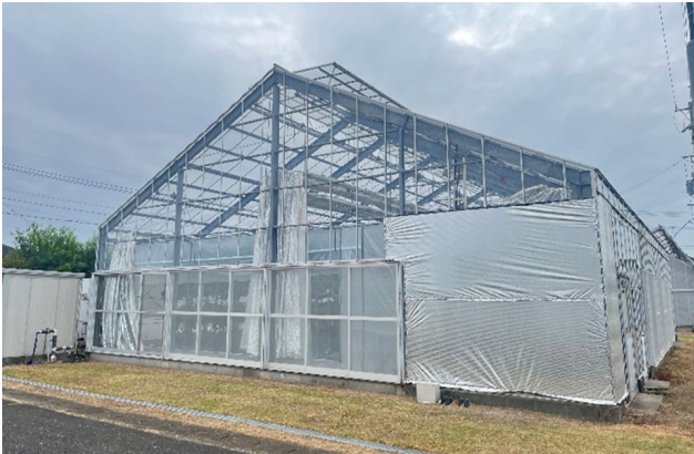
九州電力研究施設外観(佐賀市)
