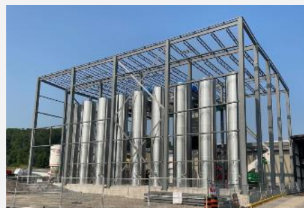
建設中のキャンベルフォード工場の新ライン(カナダ)
