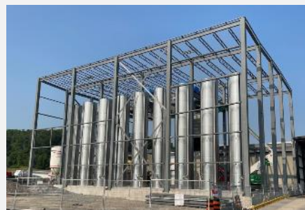
建設中のキャンベルフォード 工場の新ライン(カナダ)
