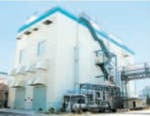
コ・ジェネレーション設備
