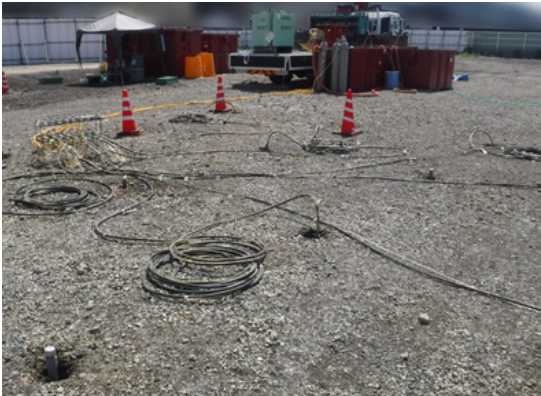
从水井注入SoyBio MA的原地净化 * 的地方
