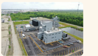
正在建设中的新奥尔良新工厂
