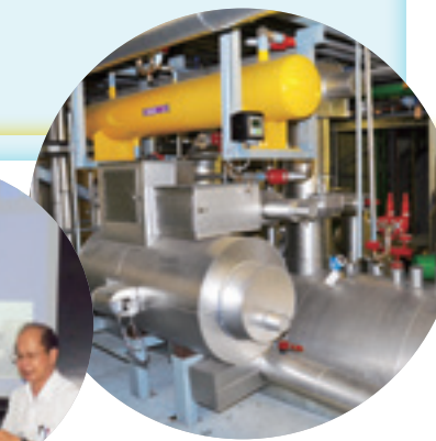
アイスコンデンス式 真空発生装置
